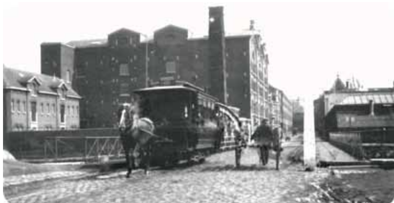
Tramway hippomobile au pont des demi-lunes à Ensival (actuellement rue Fernand Houguet) Source : http://p0.storage.canalblog.com/00/78/444499/95585846_o.jpg
